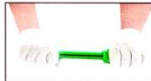
4. Setelah selesai dipanaskan, sambungkan pipa dengan socket.
