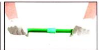
5. Setelah dipanaskan, sambungkan pipa dengan bagian socket lainnya. Pipa dan socket telah terpasang dengan sempurna.
